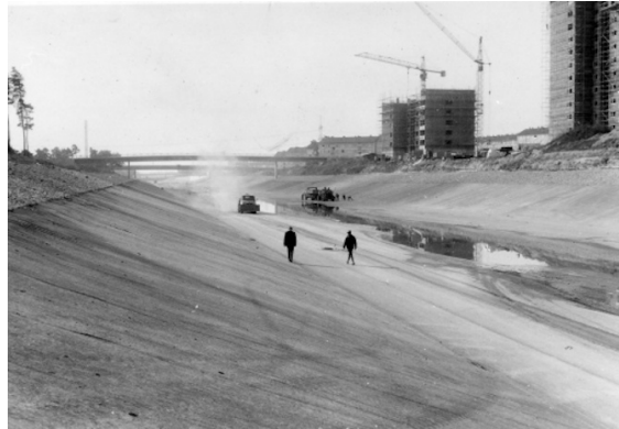
Kanalbau 1970, © WSA Donau MDK
